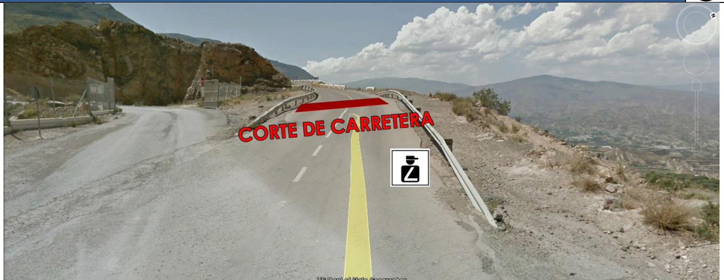
Carretera A-391 P.K. 24,8 Coordenadas: N 36°57'23.44" | O 2°35'46.05"
